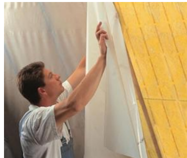
Aanbrengen van een dampscherm
