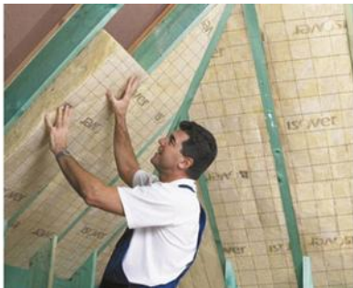
Plaatsing van dakisolatie met lambda-waarde 0,035 W/mK
